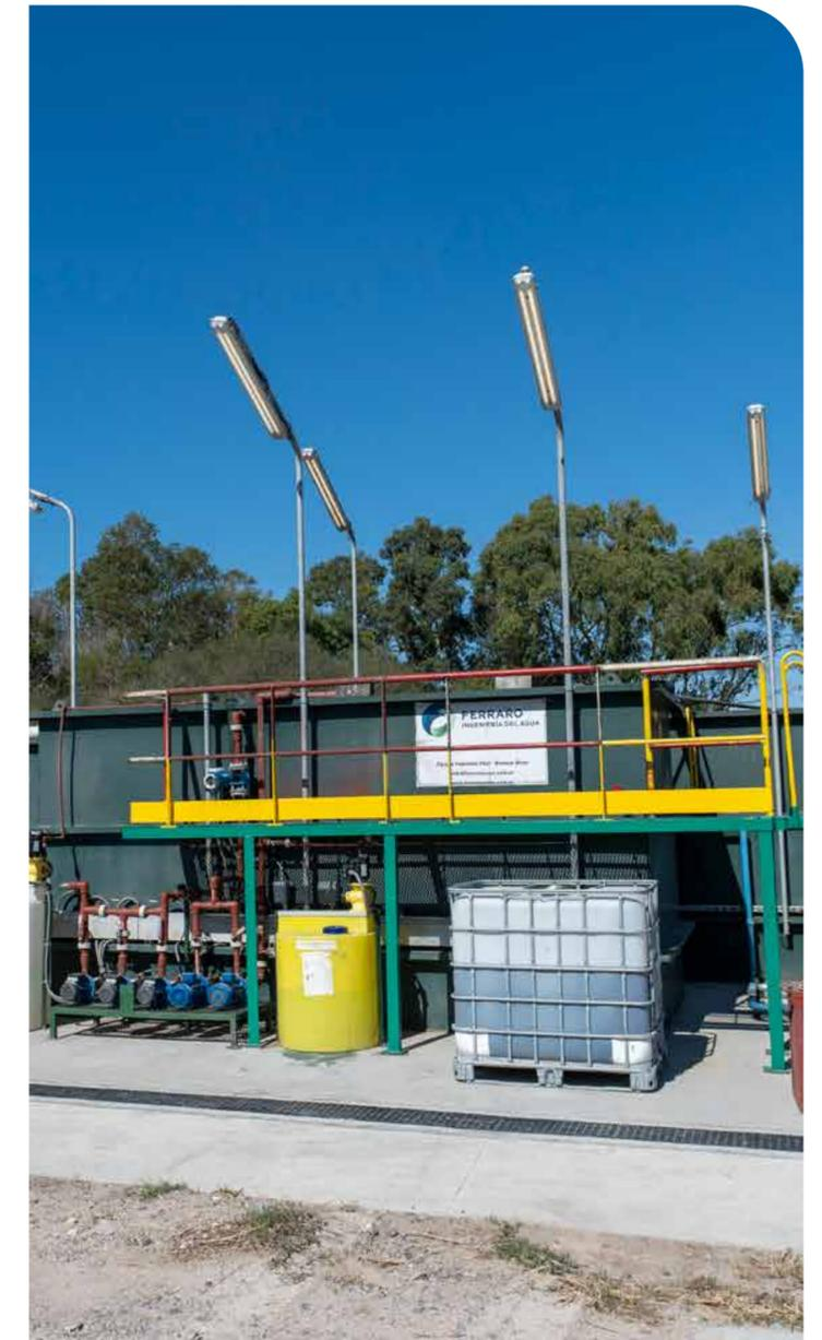
(5) Tecnología que degrada los contaminantes orgánicos con microorganismos y utiliza membranas avanzadas para rechazar los sólidos en suspensión.
