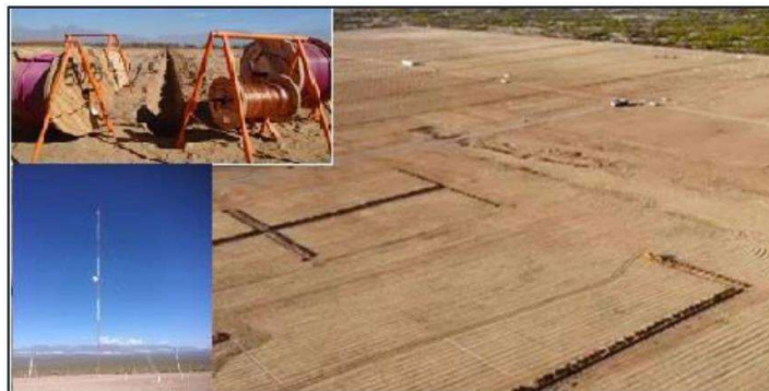
Figura 8. Zanjas, PAT, Torre Telecomunicaciones
