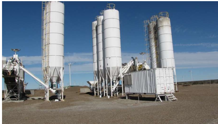
Fotografías 30 y 31. Planta de Hormigón (no se encuentra operativa).
