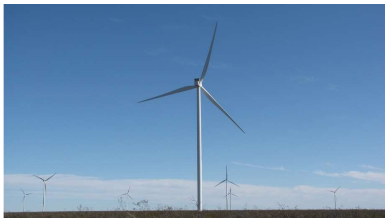
Fotografías 22 y 23. Aerogeneradores Parque Eólico Aluar Etapas I, II, III
