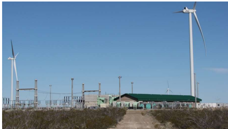
Fotografías 28 y 29. Estación Transformadora.
