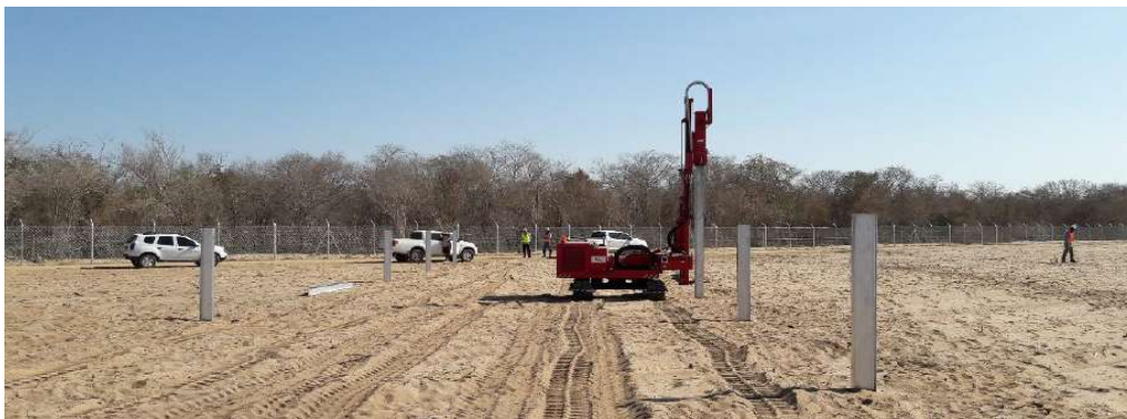
Figura 12. Hincado de postes
