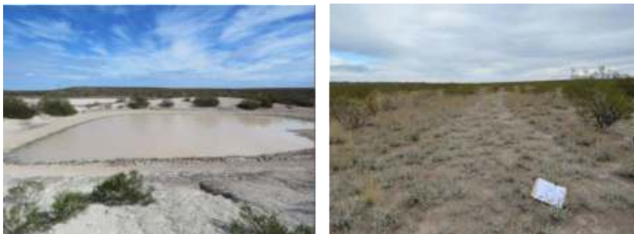
Fig. 6. Áreas impactadas en el Parque Eólico ALUAR- Etapa V “La Flecha”. Tajamares de la laguna mayor y vegetación no nativa asociada a la remoción de suelo.
