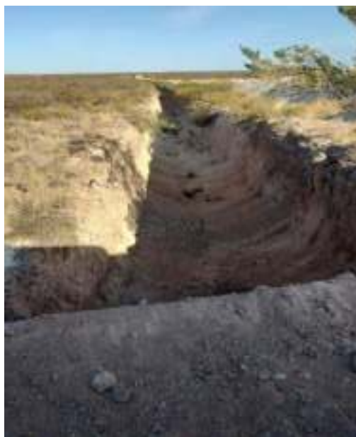
Fotografía 34. Zanja de resguarda próximo a La Flecha
