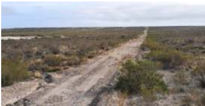
Fotografía 18. Surcos de erosión al borde del camino
